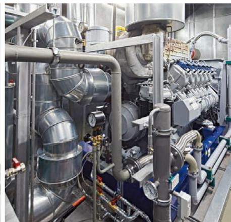
Das modernisierte BHKW 2.0 der MTU wird mit Biomethan betrieben und erzeugt Energie im Vergleich zu konventionellen Blockheizkraftwerken deutlich effizienter und schadstoffärmer.
